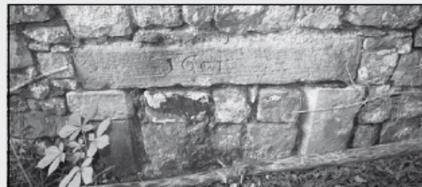
Abb. 9: Die fast vollständig zugeschwemmte Schlupftür mit der Jahresangabe 1601 auf dem Sturz am Südausgang des Klosters macht die enormen Geländeänderungen im Lauf der Jahrhunderte deutlich.
